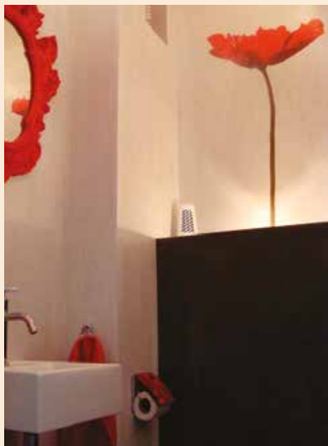
Toilet in twee kleuren estucco afgewerkt met waxlaag.
