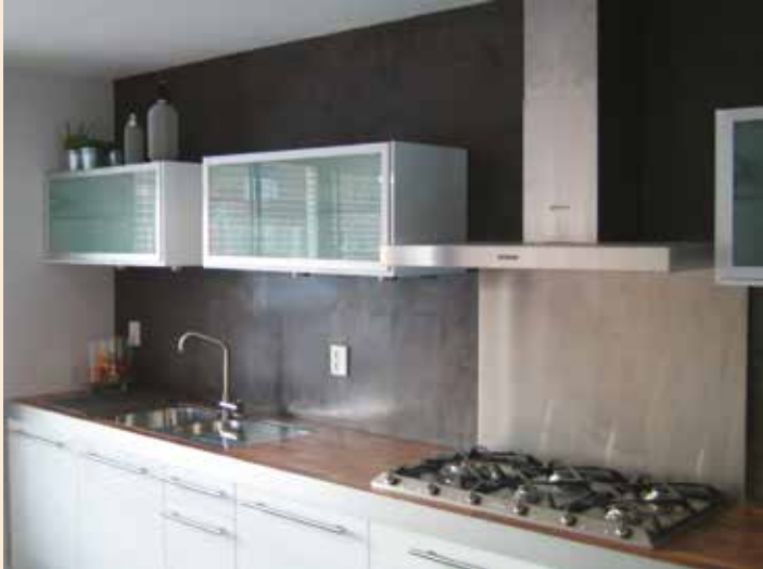
Keuken afgewerkt met estucco zwart met waxlaag.
